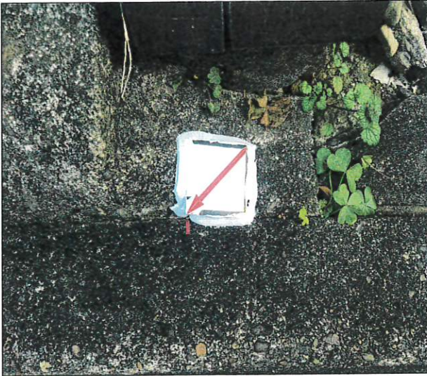
※M4 新設金属標
